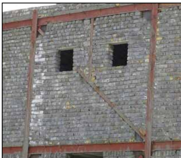
قطع بادبند جهت نصب پنجره
