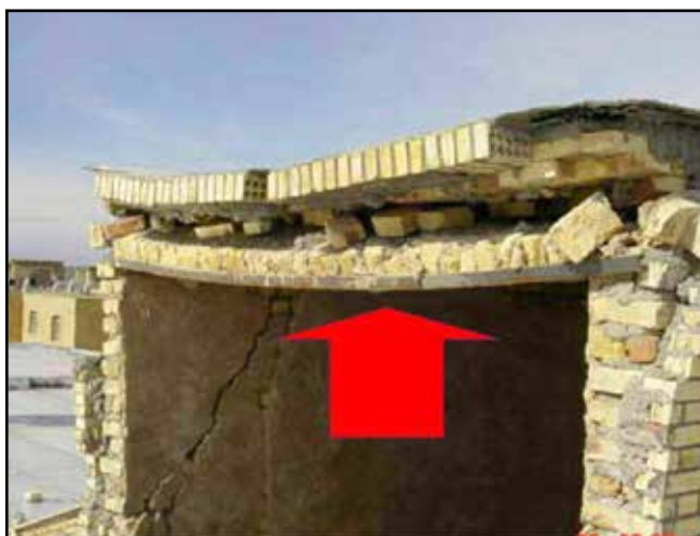
علل تخریب : حذف تیرآهن و استفاده از نبشی بجای آن - زلزله بم ۵ دی ۸۲
