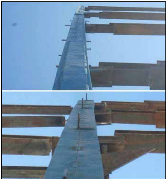
روش غلط اتصالات در سازه های فلزی
