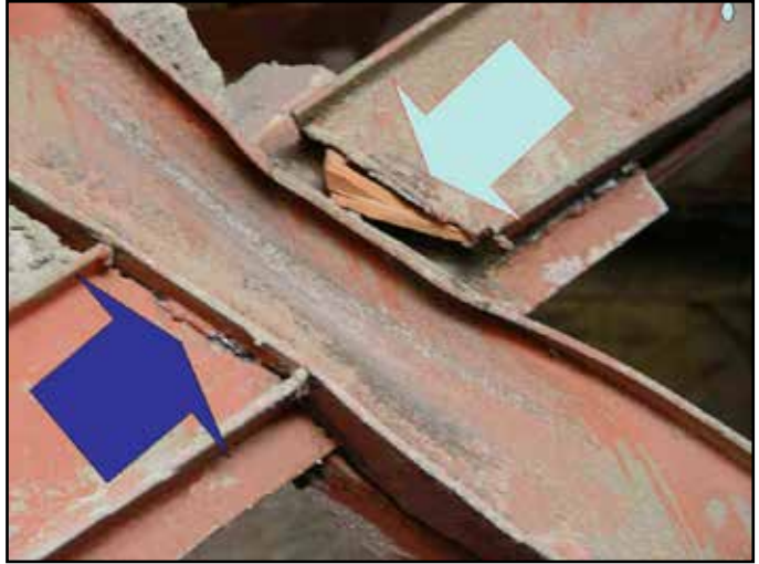
علل تخریب ضعیف بودن جوش ها و صفحه اتصال آن ها آن - زلزله بم ۵ دی ۸۲
