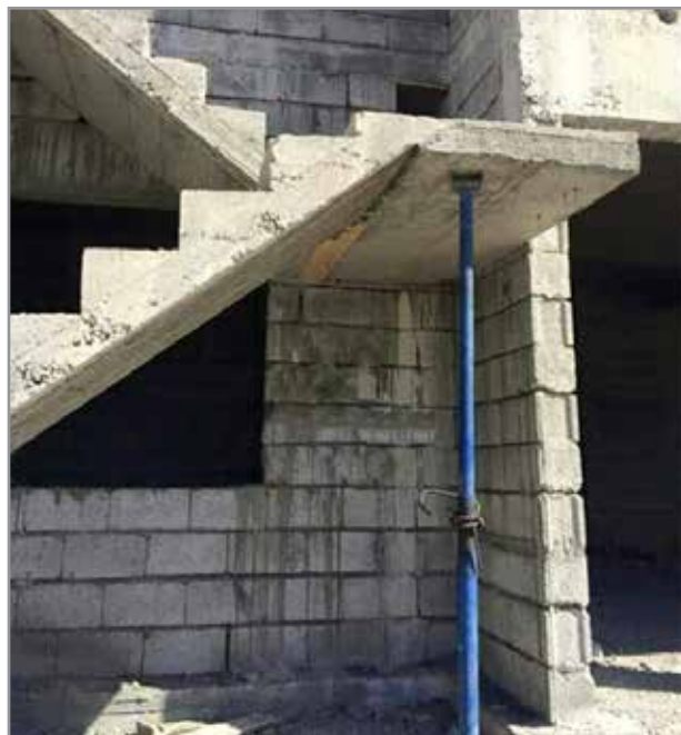
روش غلط پاگرد پله بدون تیر و ستون
