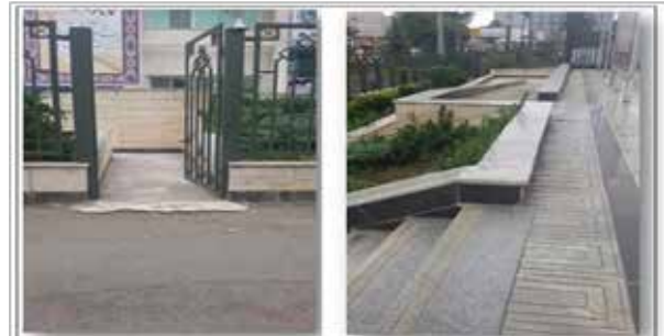
شکل ۱- عدم اجرای رمپ مخصوص معلولین، ورودی ساختمان بانک ملی رشت، ۱۳۹۴
