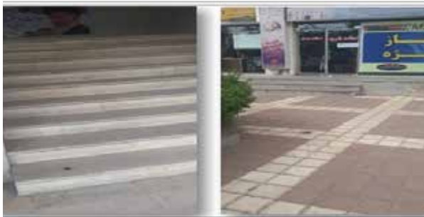
شکل ۲- عدم اجرای رمپ مخصوص معلولین، ورودی ساختمان اداره پست رشت، ۱۳۹۴
